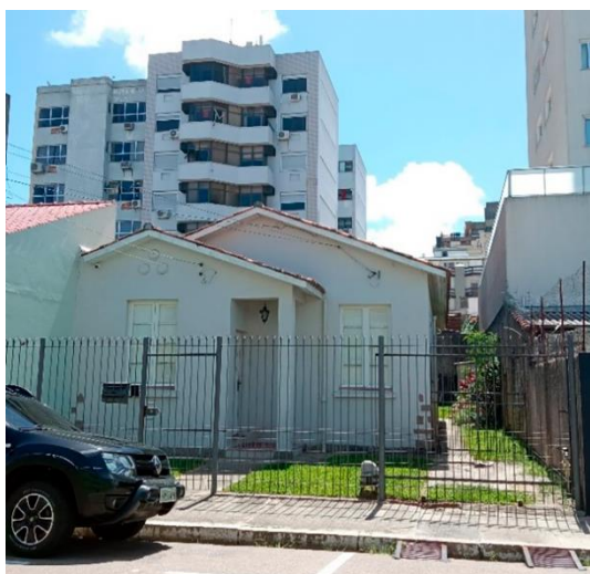
Figura 6. Exemplo de casa de catálogo, identificada na zona de estudo, localizada na Rua Santa Cruz (fonte: autoras).
