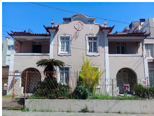
Figura 12. Exemplar de edificações geminadas, localizado na Rua Gonçalves Chaves (fonte: autoras).
