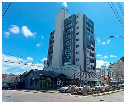
Figura 9. Vista da esquina da Rua Sta. Cruz, que torna evidente o quanto essa substituição alterou a paisagem e dificultou a leitura das edificações como um grupo (fonte: autoras).
