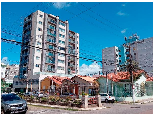
Figura 8. Exemplo de substituição por edificação em altura, identificada na zona de estudo. O conjunto de casas de catálogo conformava toda a face do quarteirão da rua Gen. Argolo e parte da rua Santa Cruz. Remanescente do conjunto localizado na Rua Gen. Argolo esquina Rua Gonçalves Chaves (fonte: autoras).
