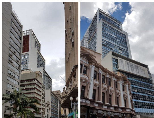
Figura 2. Edifício Santa Cruz, lado Rua dos Andradas e Rua 7 de Setembro (fonte: acervo do autor)
