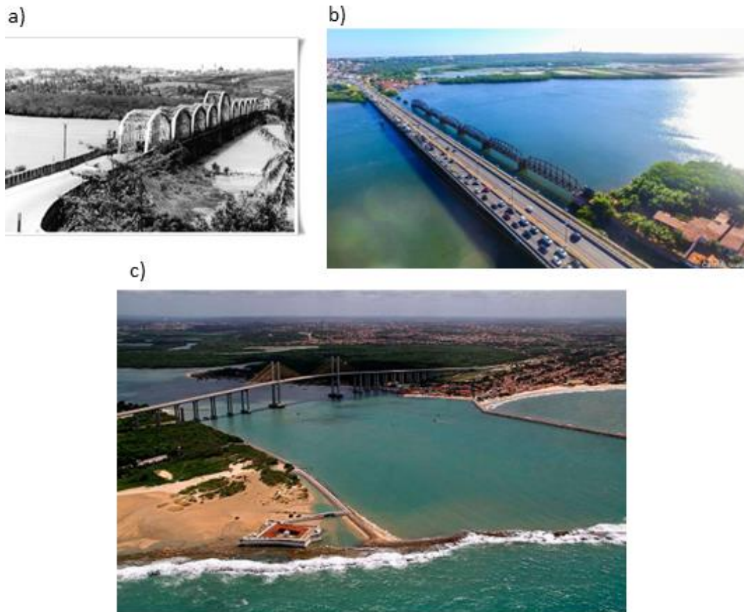
Figura 2. a) Ponte metálica (Quintas-Igapó); b) Ponte Presidente Costa e Silva; c) Ponte Newton Navarro (Santos Reis-Redinha) e o Forte dos Reis Magos, em primeiro plano (Fontes: a) https://brechando.com/wp-content/uploads/2015/09/antiga-ponte-igapo-2.jpg ; b) https://saibamais.jor.br/wp-content/uploads/2022/09/WhatsApp-Image-2022-09-15-at-12.42.59.jpeg ; e c) https://s.glbimg.com/jo/g1/f/original/2012/12/20/ponte-8.jpg ).
