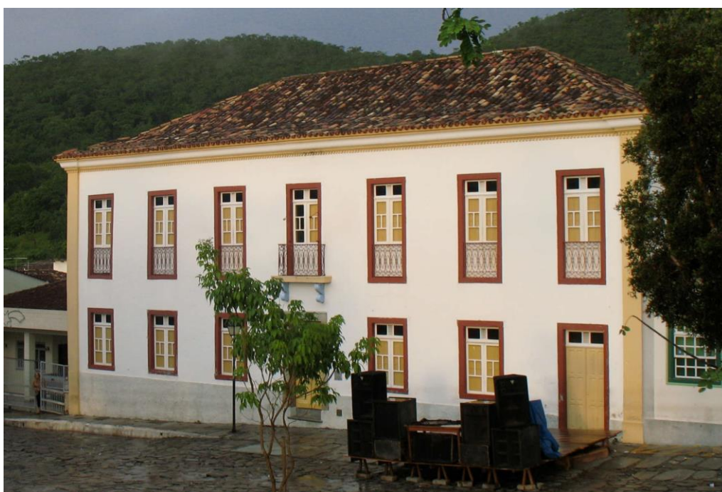
Figura 2. Real fazenda, Goiás, meados do século XVIII: exemplar de casa senhorial urbana (foto do autor, 2007)
