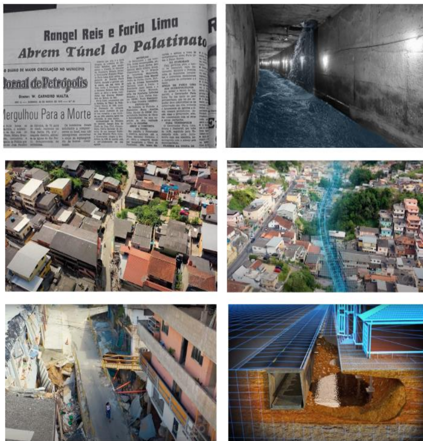
Figura 11. Imagens da Rua do Túnel e sua relação frágil com a infraestrutura subterrânea (fonte: Adaptado de Januária, 2023)
