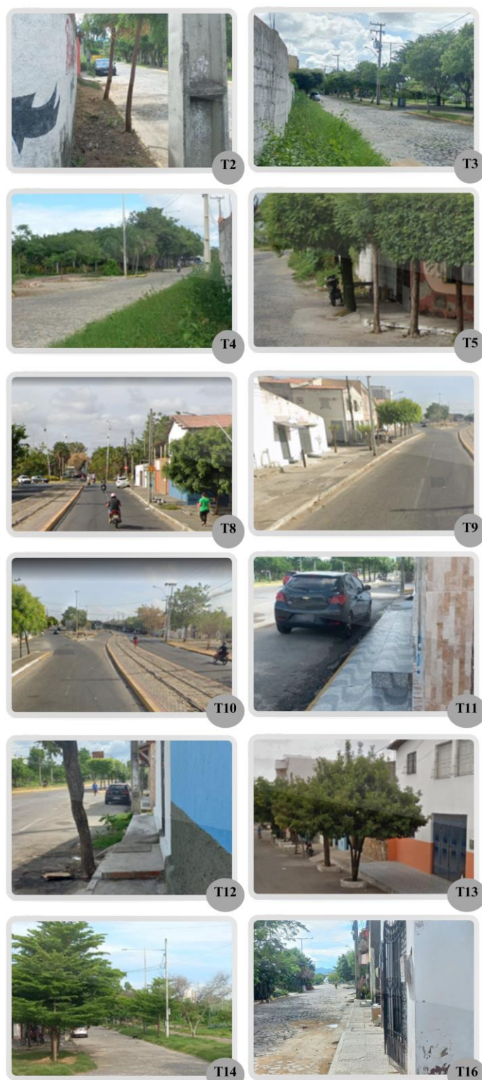
Figura 12. Registros fotográficos das calçadas inadequadas (fonte: elaborada pelos autores)
