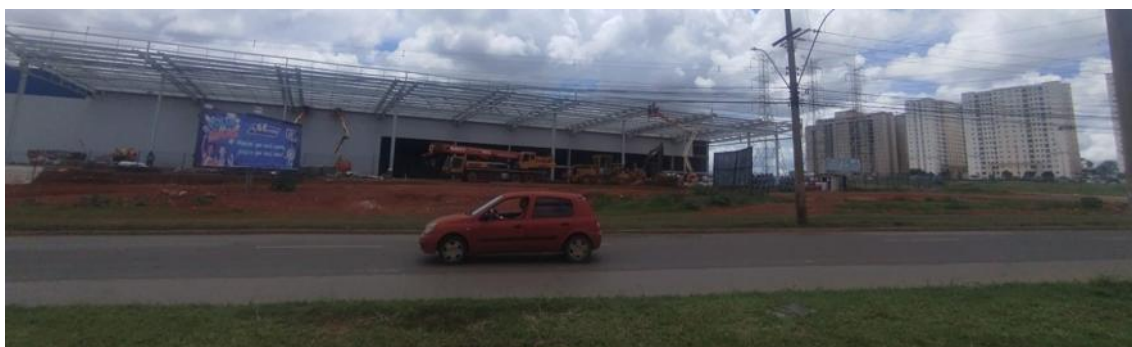
Figura 8. Centro Urbano – obra de comércio atacadista (fonte: fotografia pelos autores, fevereiro de 2026)
