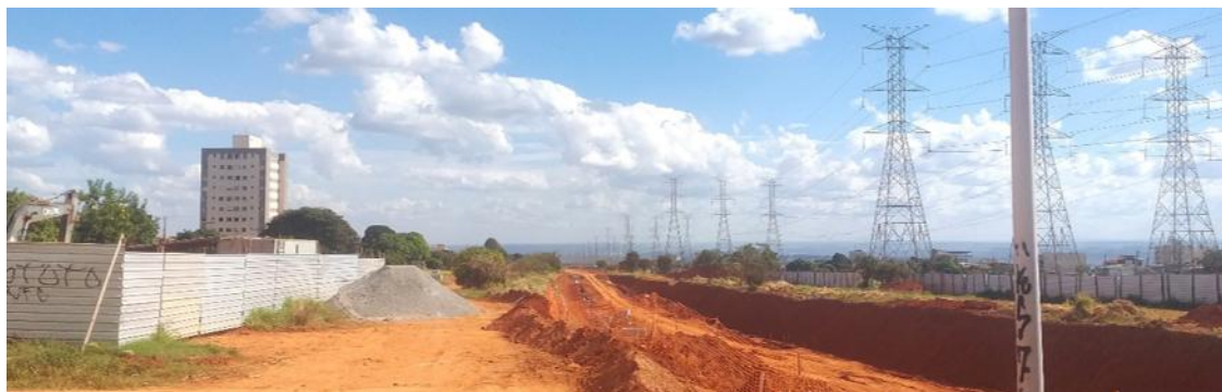
Figura 26. Obras de expansão do metrô em Samambaia e obra de edificação (fonte: fotografia pelos autores, junho de 2026)
