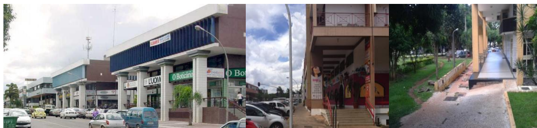
Figura 5. a) Rua do comércio local da Asa Norte, CLN 309 (fonte: sítio:www.brazilia.org.df , 2012). Edifício inserido sobre platô: espaço de movimento do pedestre fragmentado; b) CLN 207 (foto: Matheus Henrique e Karen Cecilia, 2014); c) CLN 110 (foto: Viridiana Gomes).
