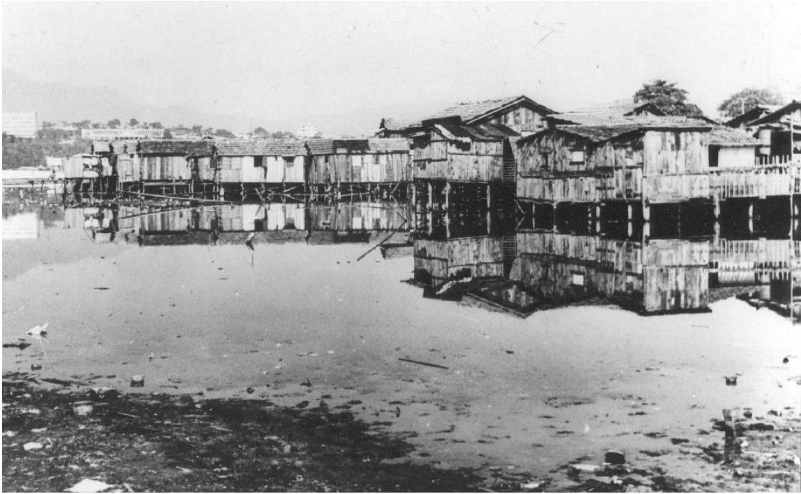
Figura 4. Trecho da Comunidade Baixa do Sapateiro mostrando as palafitas do início de seu surgimento (fonte: adaptado de Museu da Maré).
