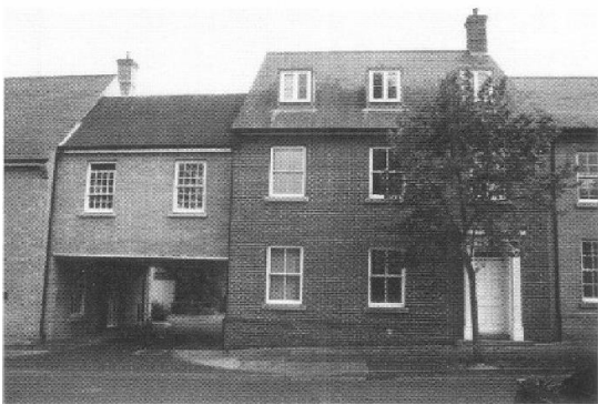
Figura 3. Fachada de rua moderna em Bury St Edmunds, Inglaterra, onde uma variedade inadequada de materiais foi usada em edificações que, de outro modo, apresentariam sensibilidade no preenchimento urbano.
