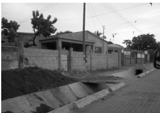
Figura 3. Intervenção ao nível da infraestruturização dos bairros: instalação de valas de recolha de águas no Bairro de Polana-Caniço de modo a minimizar efeitos como os que decorreram das cheias de 2000.
