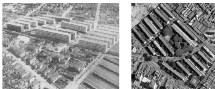
Figura 12. Conjunto residencial IAPI Mooca, imagem geral e vista aérea.
