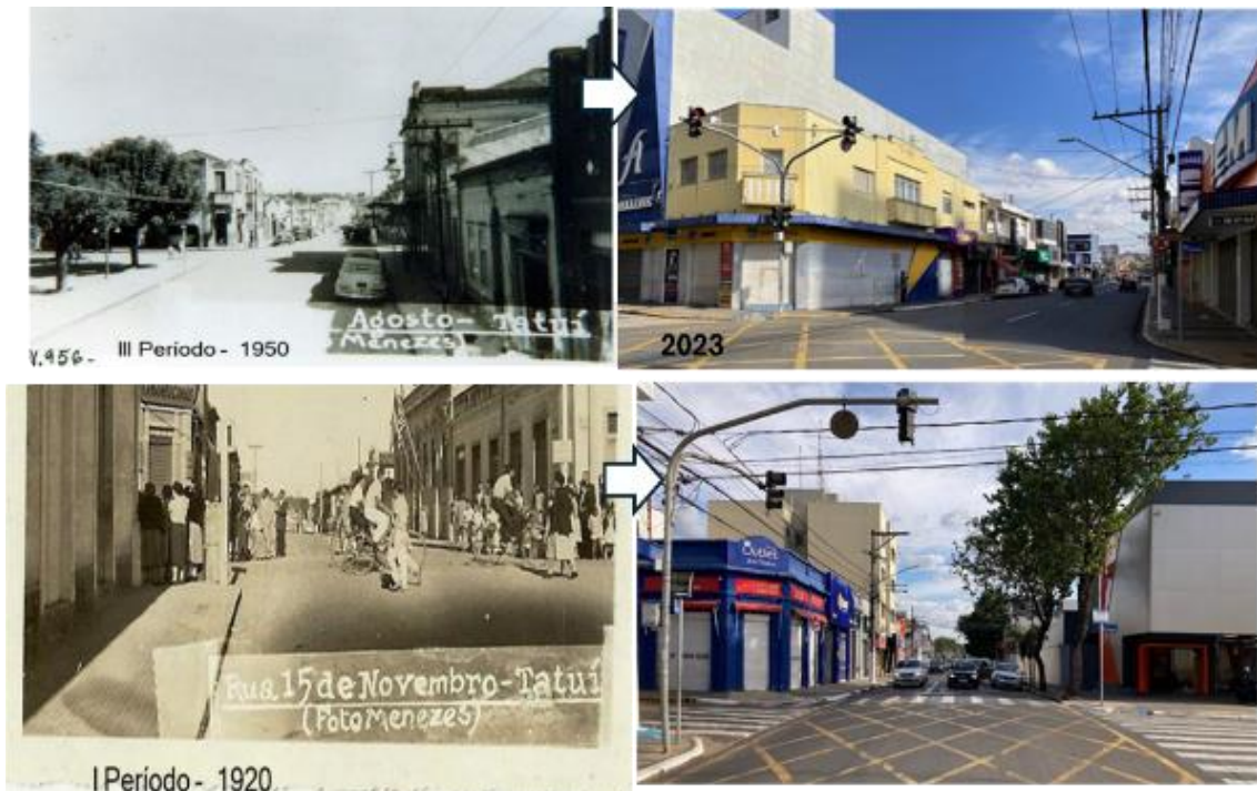
Figura 2. Qualidade e alterações dos edifícios nas ruas centrais de Tatuí (fonte: Laura Rodrigues de Souza, Acervo: Disciplina AQ104/2024.PPGATC- Unicamp)
